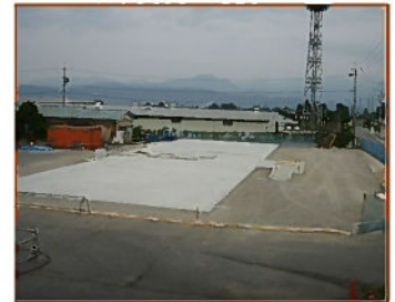
基礎工事 全景
