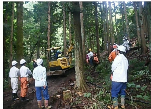
路網整備推進！ 作業道開設研修(22.9.1～3)
